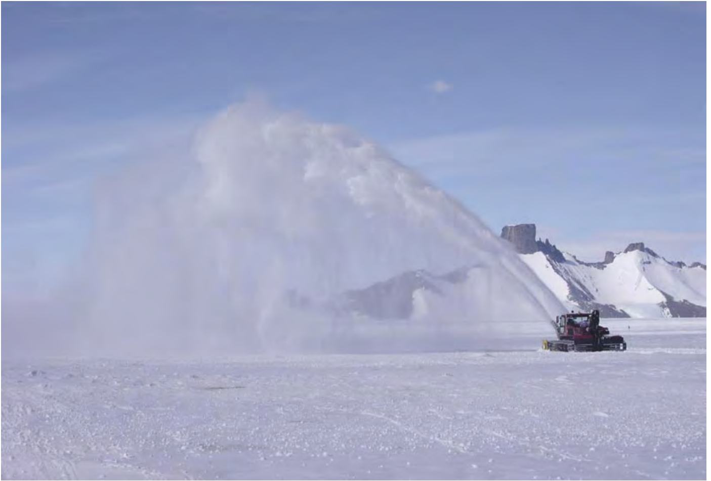
Preparering av den nye landingsstripen Troll Runway ved Trollstasjonen. Fjellet bak er Stabben, 1887 moh. Foto: S. Vaadal Preparing the ice at Troll Runway. The mountain in the background is Stabben, 1887 masl. Photo: S. Vaadal
