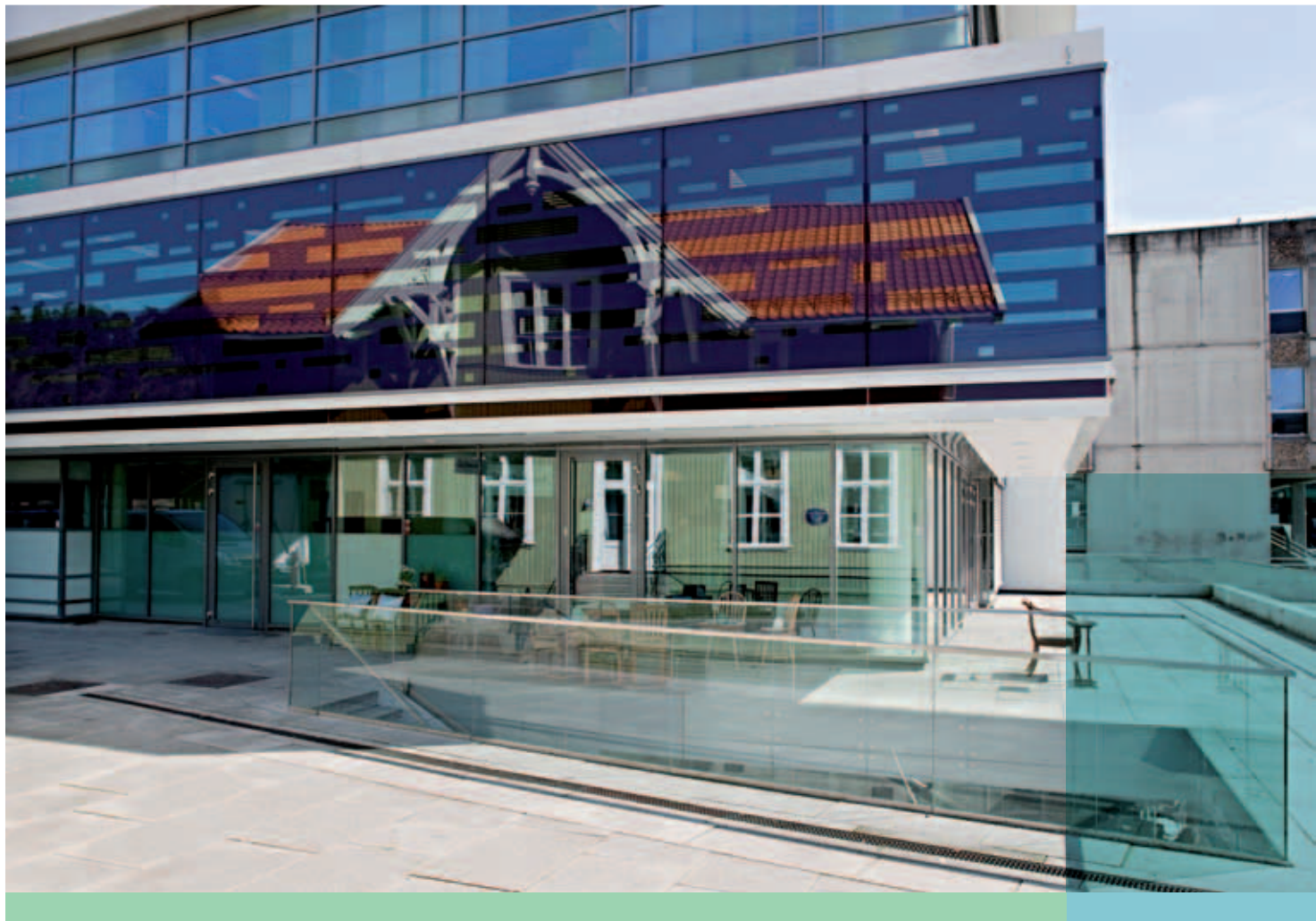
Sandvika stasjon and Skattens hus, Malmskriveveien 18 and 20, Sandvika
