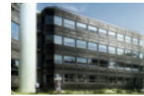
Renovates Powerhouse, Kjørbo
