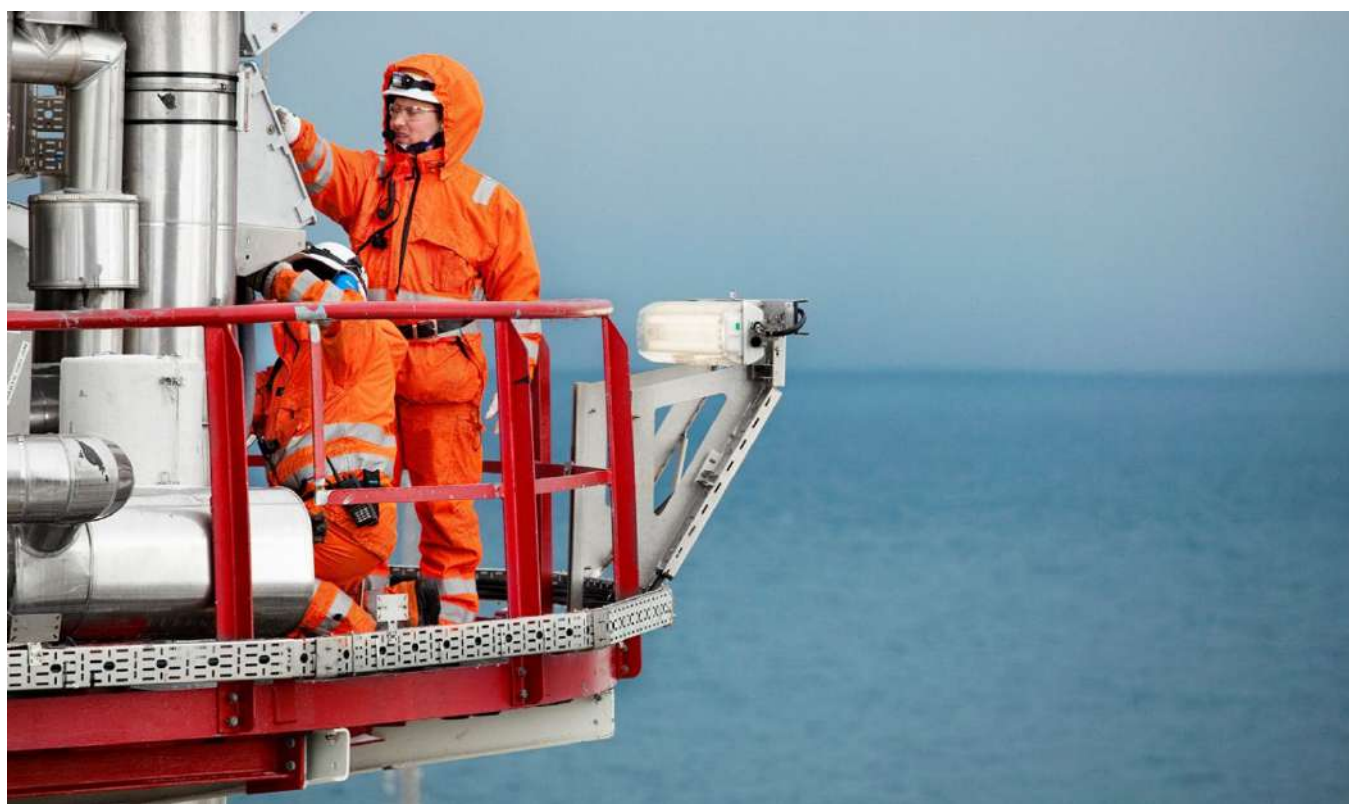
Hammerfest LNG plant, Melkøya
