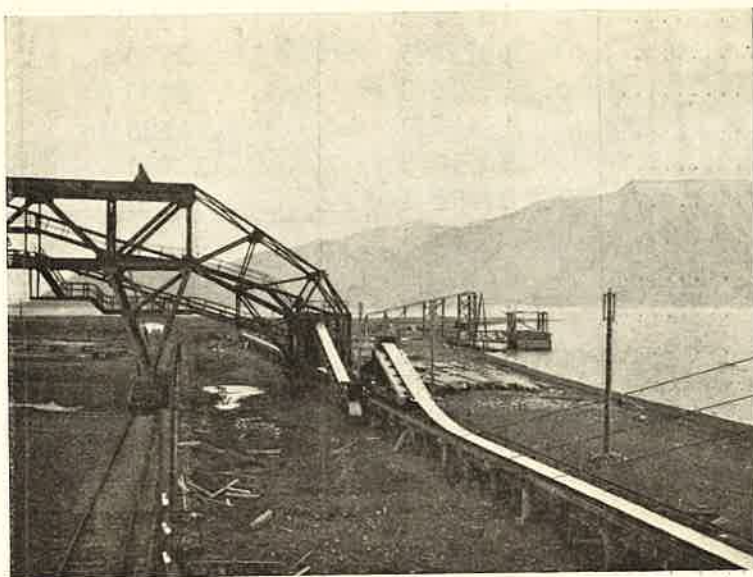
Fig. 17. Transportbaand (conveyors) som fører kul fra taugbanens endepunkt til lagringsbroen eller til kaien.
