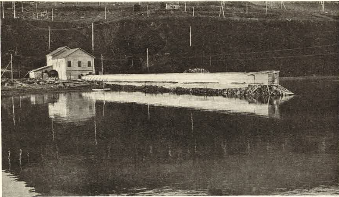
Fig. 12. Den nye kraftstation paa 750 hk. med kjølevandsindtak paa jeté set fra Advent Bay.
