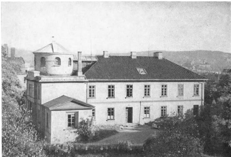
Fig. 1. Norsk Polarinstituttets kontorbygning i Observatoriegte 1, Oslo. Foto: T. S. WINSNES
