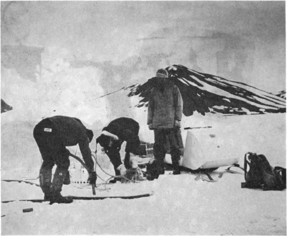
Fig. 2. Snøscooter og smeltebor med sirkulerende varmt vann var nye hjelpemidler som lettet glasiologene vesentlig i deres arbeid. Foto: O. LIESTØL.
