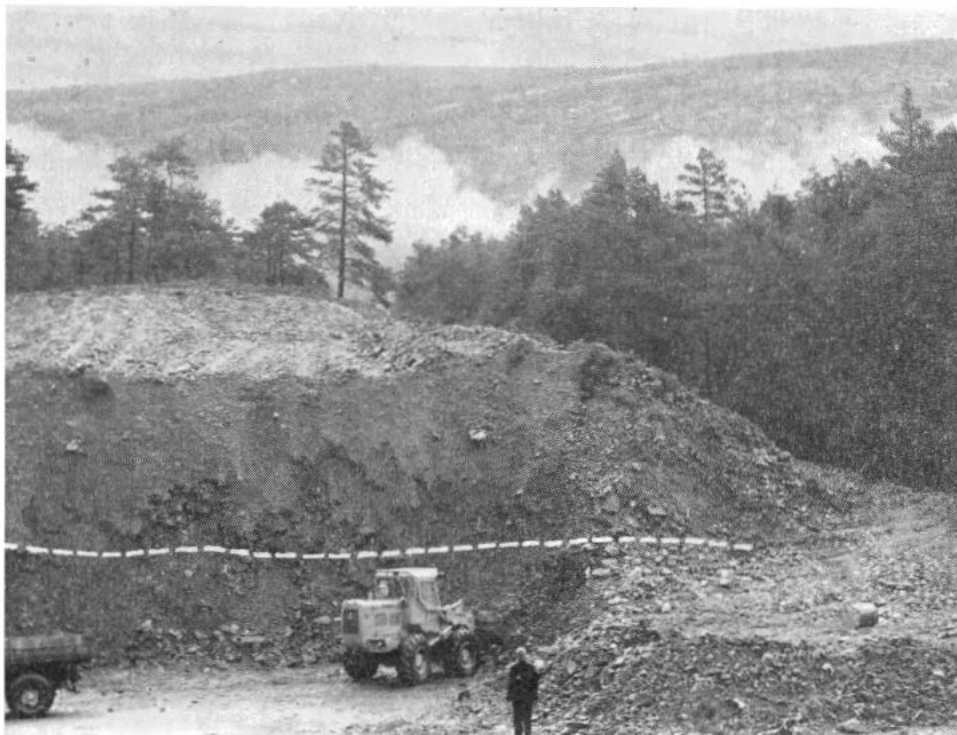
Fig. 2. Fotografet viser grustaket i den sørligste del av permafrostområdet.
