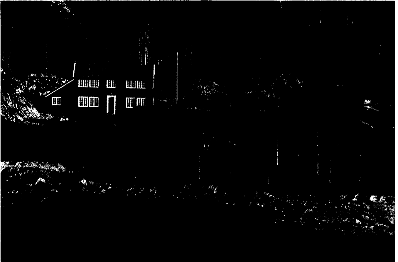
Einskildhus på Sørlandet. Justøya ved Lillesand. Nytt hus i gammalt, etablert miljø. Arkitekt: Tor Arne Revheim.
