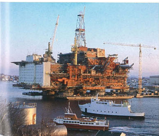
Statfjord B-dekket under bygging i Stavanger.
