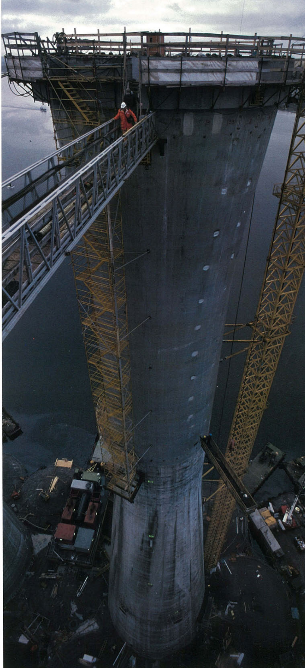
Et av Staffjord B's fire skaft gir idé om plattformens størrelse.
