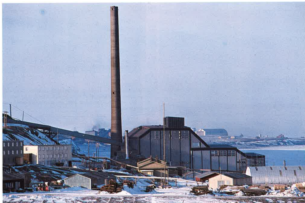
Det nye kraftverket.
