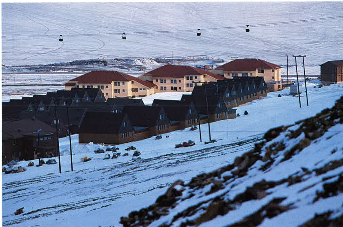
Parti fra «Hilmar Rekstens vei» med det nye hybelhuset i bakgrunnen.
