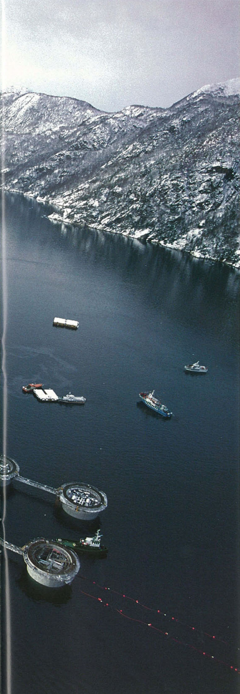
Statfjord C-dekket ble koblet sammen med betongdelen i Yrkjefjorden nord for Stavanger i februar 1984. Ovenfor ser vi ståldekket ved Moss Rosenberg Verft i Stavanger før det ble slept til Yrkjefjorden.
