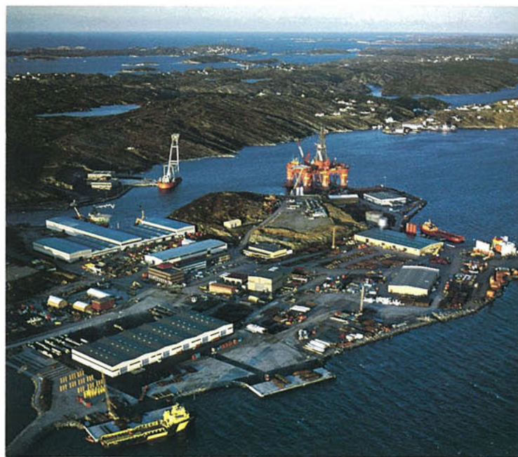
Coast Center Base på Sotra er gjort klar for nye oppgaver, blant annet de som følger med utbyggingen av Gullfaks-feltet.
