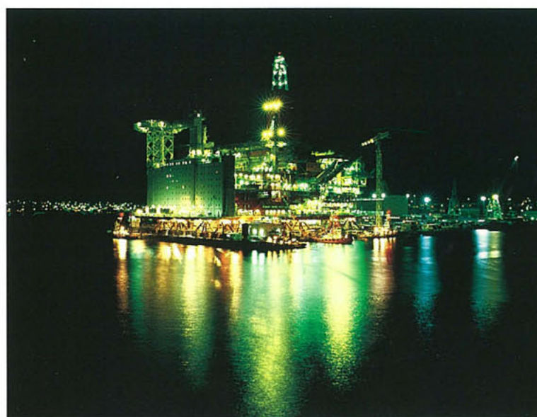
Statfjord C-dekket ble koblet sammen med betongdelen i Yrkjefjorden nord for Stavanger i februar 1984. Ovenfor ser vi ståldekket ved Moss Rosenberg Verft i Stavanger før det ble slept til Yrkjefjorden.
