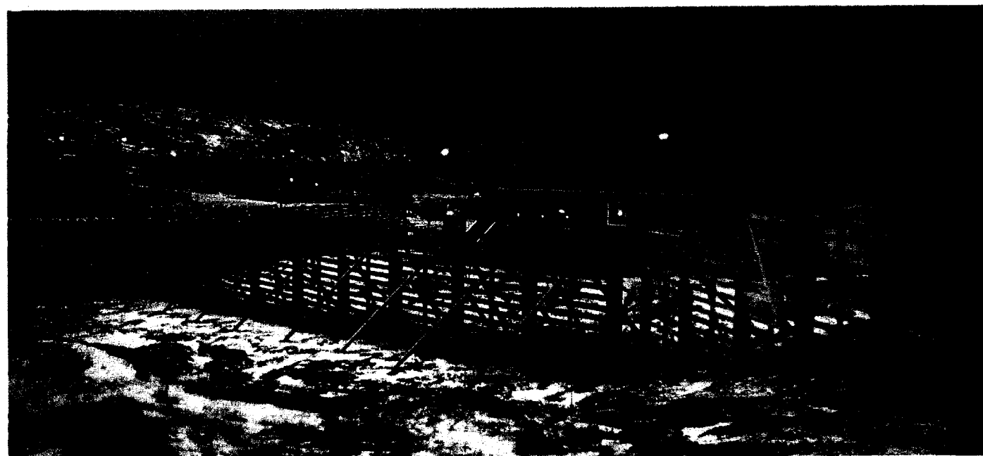
Levegger beskytter mot vind og vær. Dette bildet er fra et annet værhardt område i Finnmark – Bugøyenes i Sør-Varanger.
