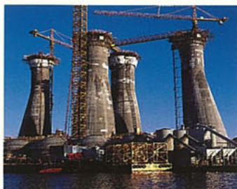
Betongunderstellet til Sleipner-A plattformen. Skafteøyden er 47 meter.
