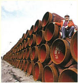
1000 km rør til Zeepipe. Hver av de 12 meter lange rørene veier opptil 25 tonn.
