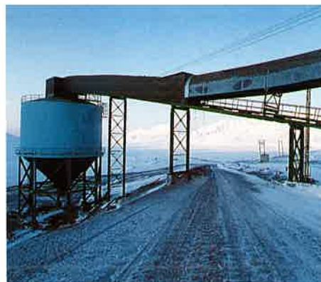
Kullsilos ved fjellfoten Gruve 7
