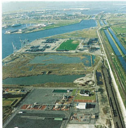
Terminalen i Zeebrugge
