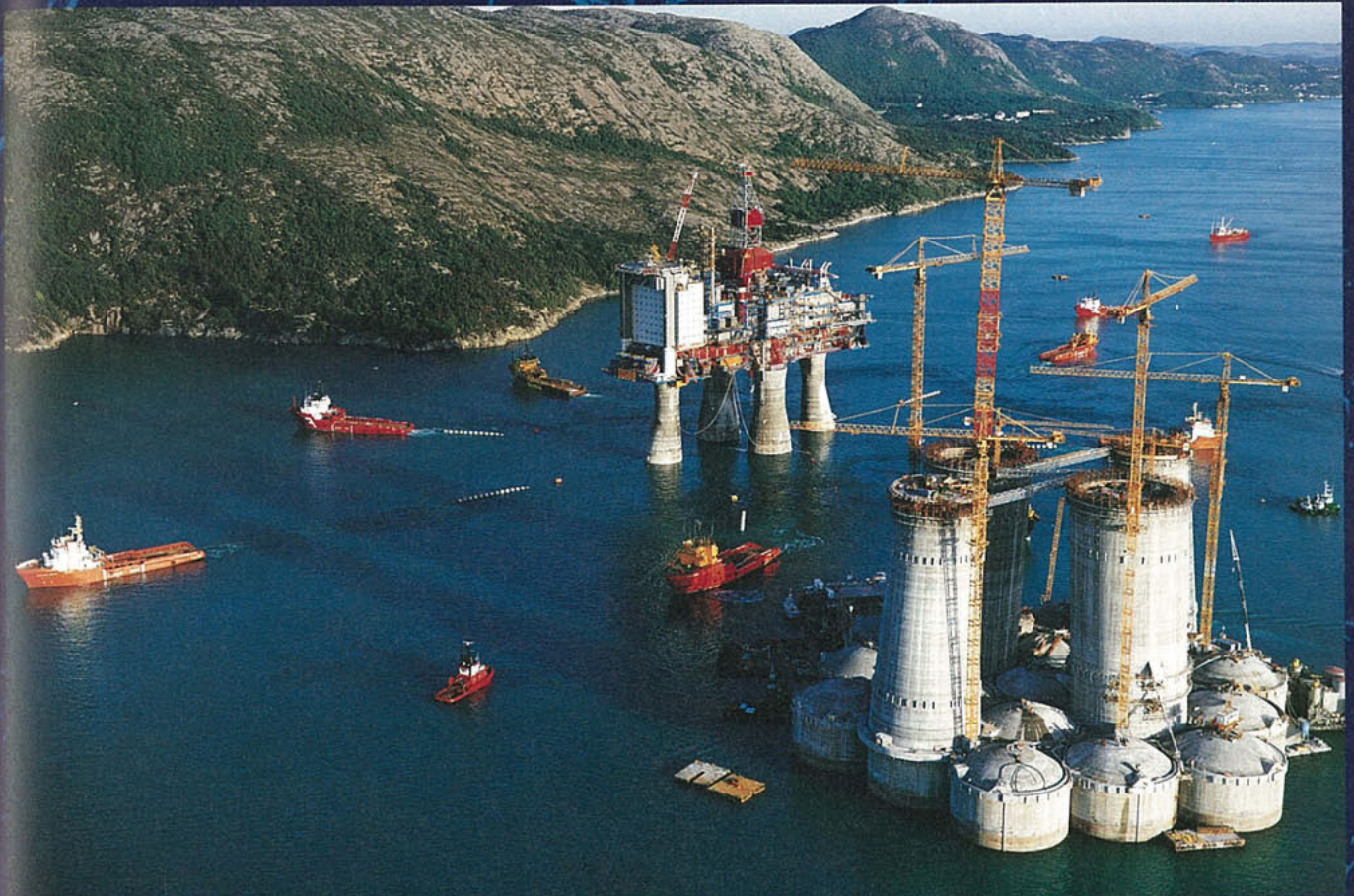
I begynnelsen av juni 1993 ble Sleipner A-plattformen slept til feltet. På vei fra byggeplassen i Gandsfjorden i Stavanger passerte den understellet til en annen norsk gassplattform, Trollplattformen, som er verdens høyeste i sitt slag.
