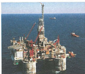
HEIDRUN ØKER: På Heidrunfeltet er produksjonskapasiteten oppgradert fra 220 000 til 250 000 fat per dag.
