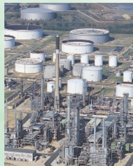
STATOILS RAFFINERI I KALUNDBORG, DANMARK.
