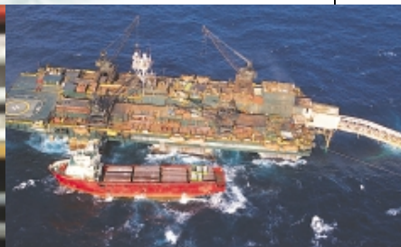
RØRLEGGING AV EUROPIPE II.
