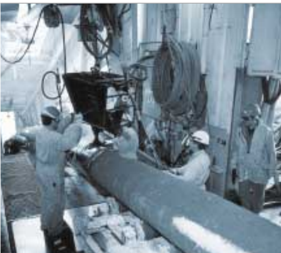
Legging av gassrør mot Åsgard.
