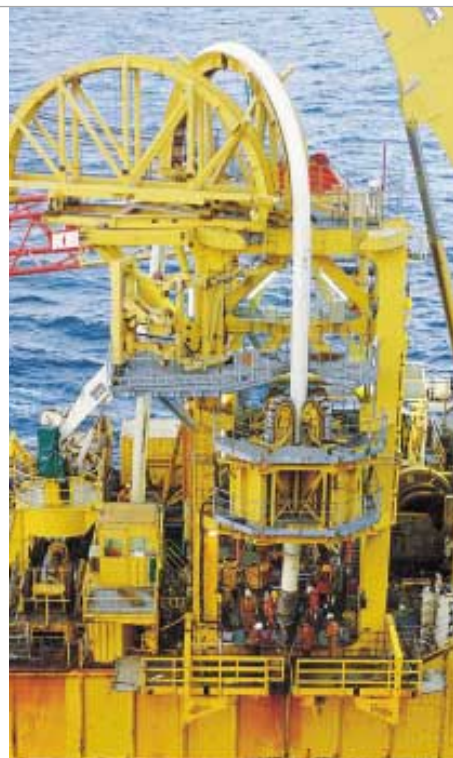
Oppkopling av havbunnsbrønner til Åsgard B.
