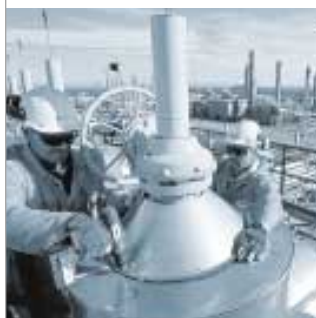
Ferdiggjøring av de nye anleggene på Kårstø.
