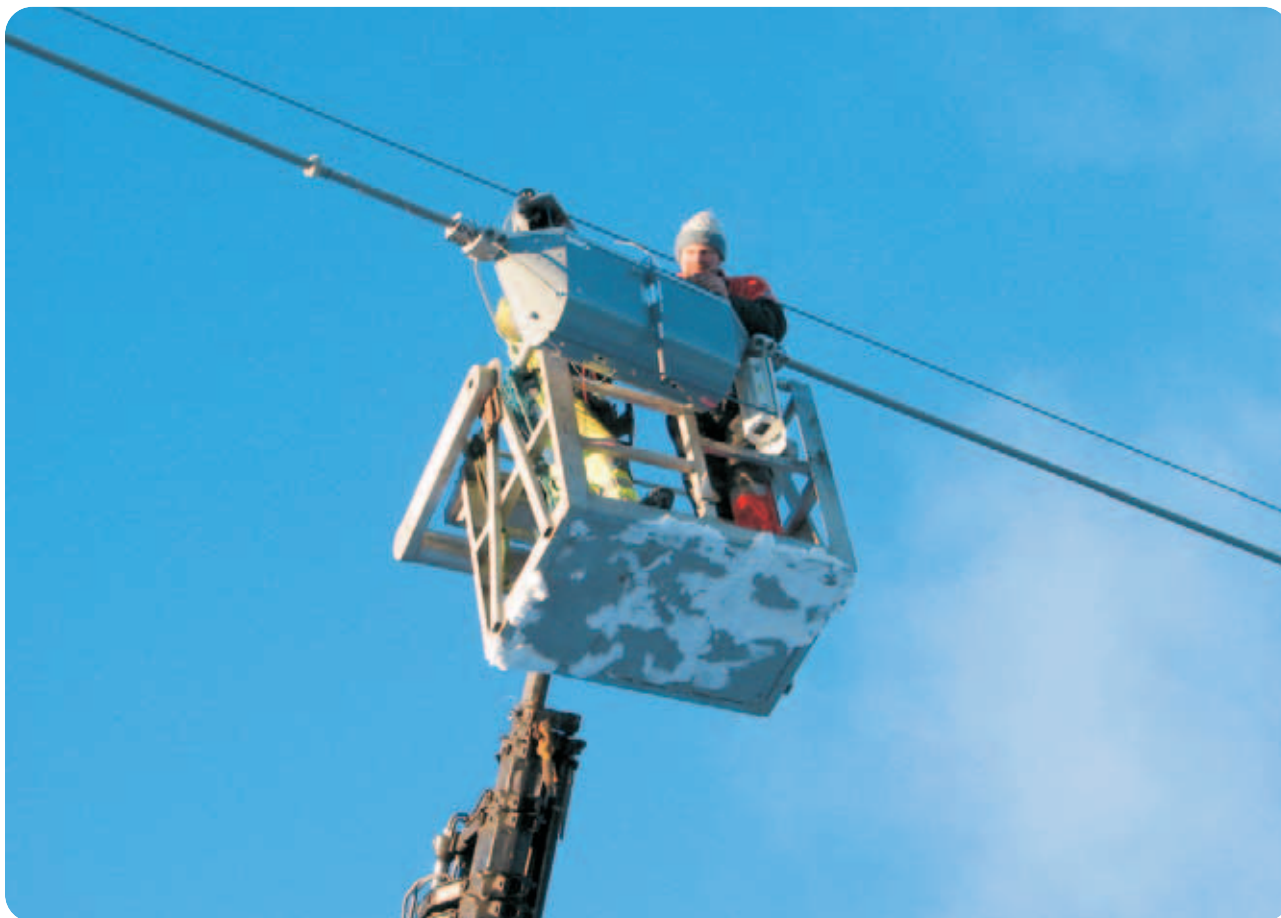
Testversjonen av den vibrerende isfjerner ble installert på en av Statnetts kraftledninger av oppfinneren selv, Roger Hansen.
