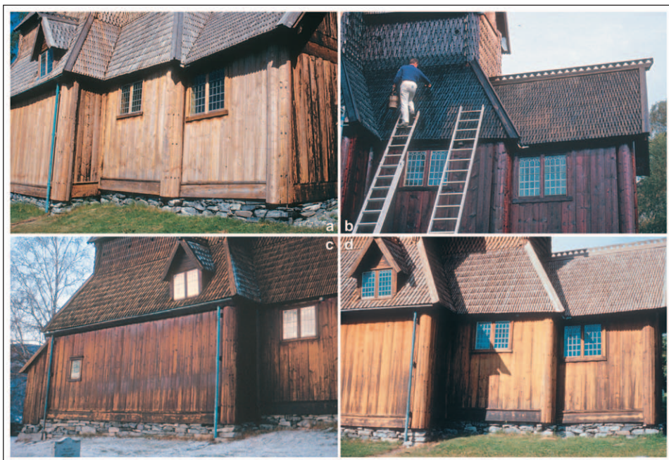
Urnes stavkirkes sydfasade 1993-94: a) Tre måneder før tjærebreing 1993 b) Sydfasaden tjærebres 1993. c) Tre måneder etter tjærebreing 1993 d) 10 måneder etter tjærebreing, 1994.
