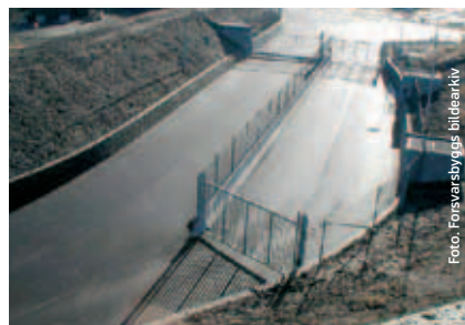
Fysisk sikring – ett av spesialområdene for Forsvarsbyggs rådgivningstjenester.
