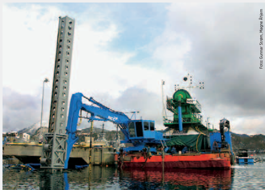
Spesialutviklet: Miljøsaneringen på Haakonsvern er basert på utviklingsarbeid på høyt teknologisk nivå.
