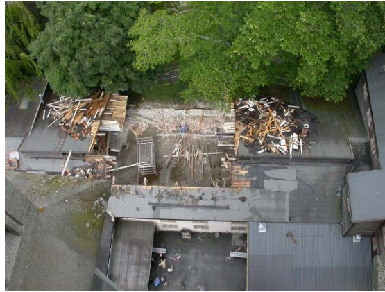
Bildet viser den delen av verkstedet som ble demontert, og som vil bli gjenoppbygd inne i Vestfrontbygget. Det ble tatt ned ca. 12 m i lengde av den gamle steinhuggersalen.
