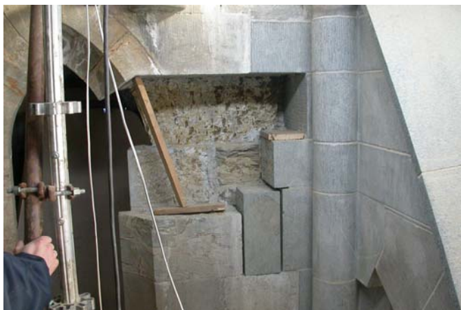
Steinutskifting i overgangen mellom DSU 203 og 303 under arbeid.
