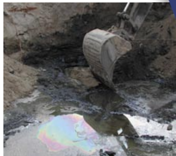
Undersøkelser av forurenset jord på nedlagt gassverkstomt i Halden. Foto: O. Nordal
