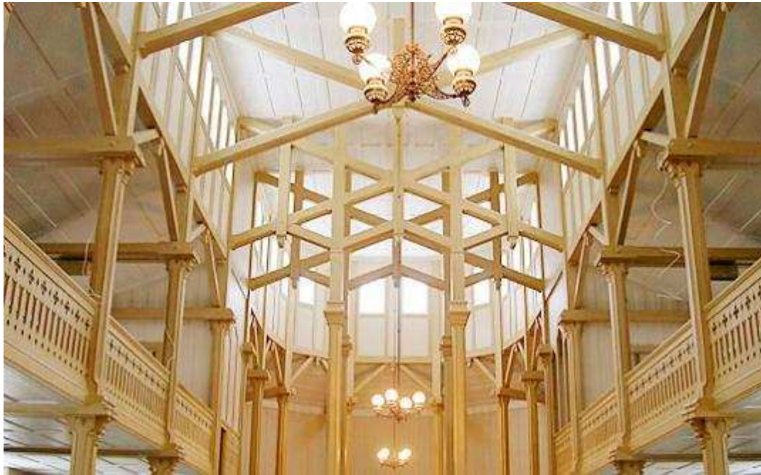
Kirken er en basilika, med løftet midtrom, som gir kirken en lyst og vakkert rom. Foto: Riksantikvaren.
