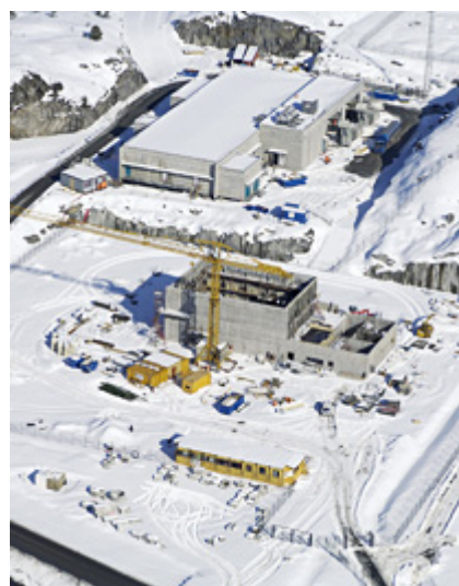
Statnetts arbeid med ny kraftledning fra Viklandet til Nyhamna (bildet) sluttføres i 2006. (Foto Hydro: Leren)
