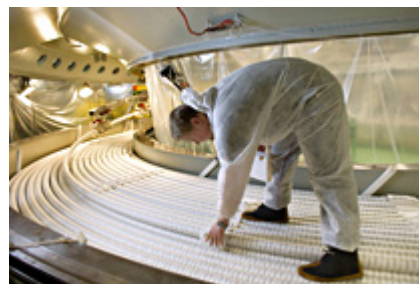
Impregnering av NorNed-kabelen ved Nexans fabrikk i Halden.
