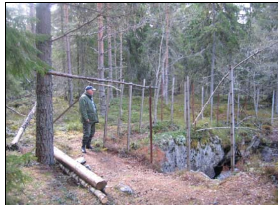
Figur 4.2 Typisk sikring av tidligere gruvegrift.
