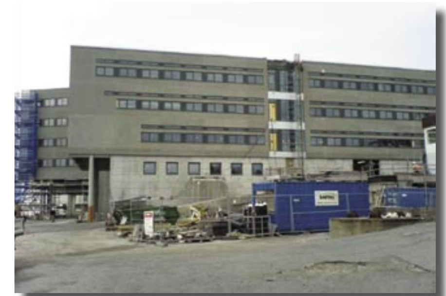
NYBYGG. Det nye Sjøfartshuset i Haugesund er i ferd med å ta form.
