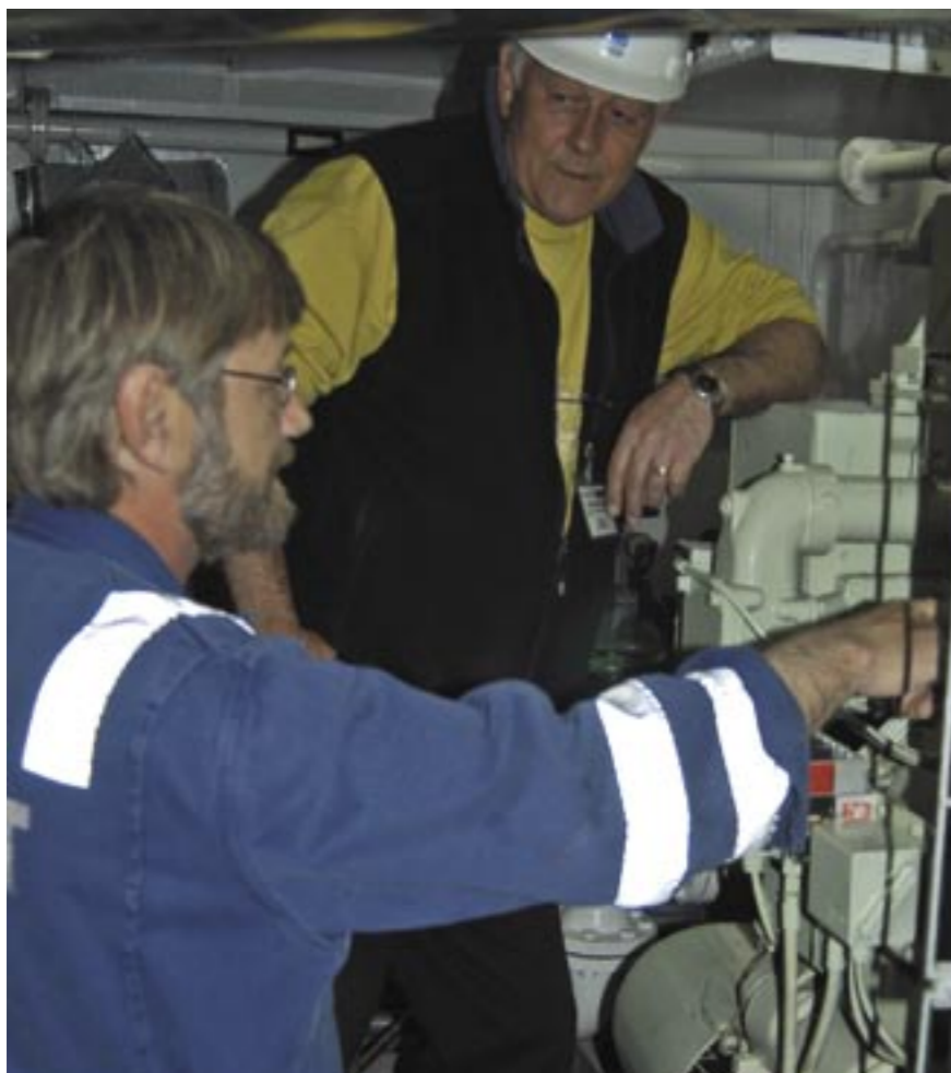
MASKINSJEKK. Inspektør Torbjørn Ibenfeldt fant ingenting å utsette i maskinen om bord på danske "Esvagt Corona".
