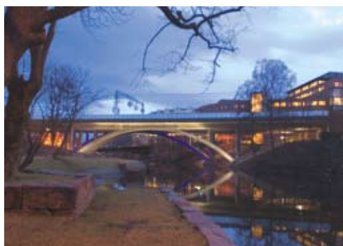
De nye jernbanebruene over Sandvikselva i sentrum av Sandvika. Foto: Rune Fossum
