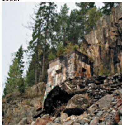
Langenes Brogalleri i Spydeberg kommune. Brogalleriet er delvis utsprengt med oppmurte mitraljøsestillinger som skulle beskytte jernbanebroen over Glomma.
