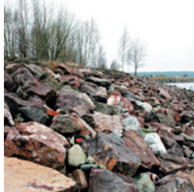
Godt tettet: Langs sjøsidene er deponiet plastret inn, og stein er lagt inntil for å gi området en fin avslutning mot strandkanten.
