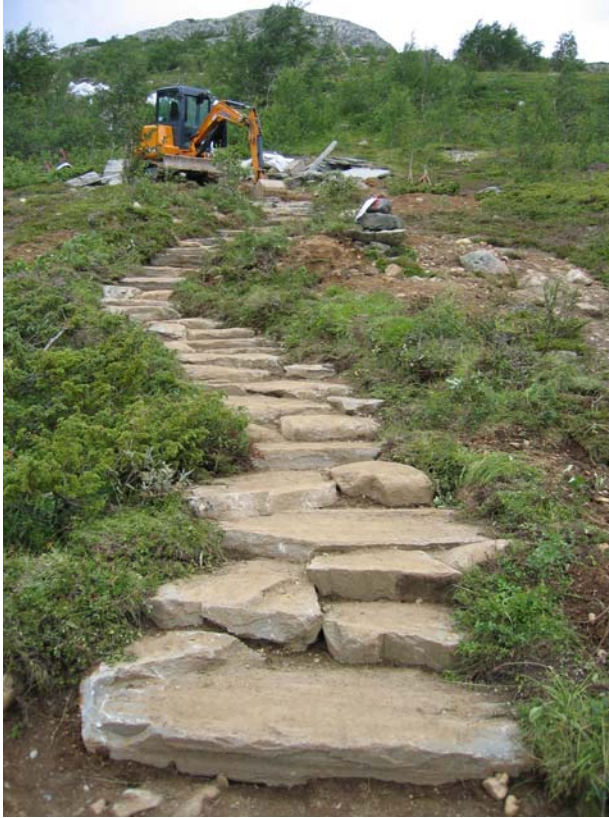
Stiprosjektet ved Besseggen i Jotunheimen er det mest omfattende tilretteleggingsprosjektet SNO har igangsatt. Her et parti av stien opp fra Gjendesheim som viser hvordan stien naturlig legges i terrenget og nærområdet som revegeteres av stedeagne planteslag. (Foto: D.Claudius)
