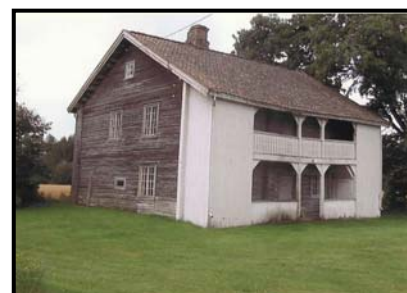
Svalgangsbygning Øst-Nor, Kongsvinger
