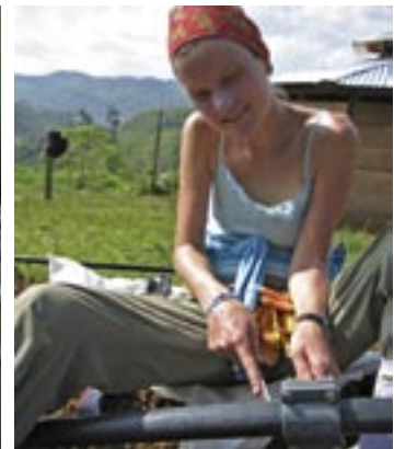
Marit Mastad skrur til et rør i et vannprosjekt i Chiapas, Mexico
