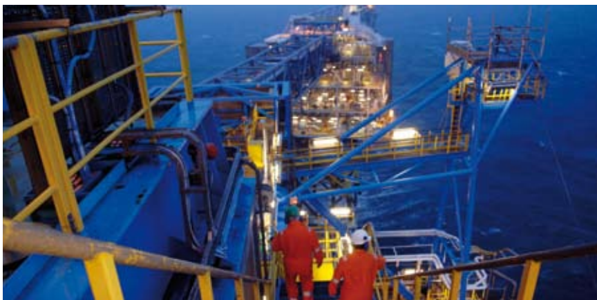
Mange plattformer på norsk sokkel er allerede koplet til kontrollrom på land gjennom fiberoptisk kabel som gir helt nye muligheter for overføring av data – og dermed for større integrasjon mellom hav og land.
