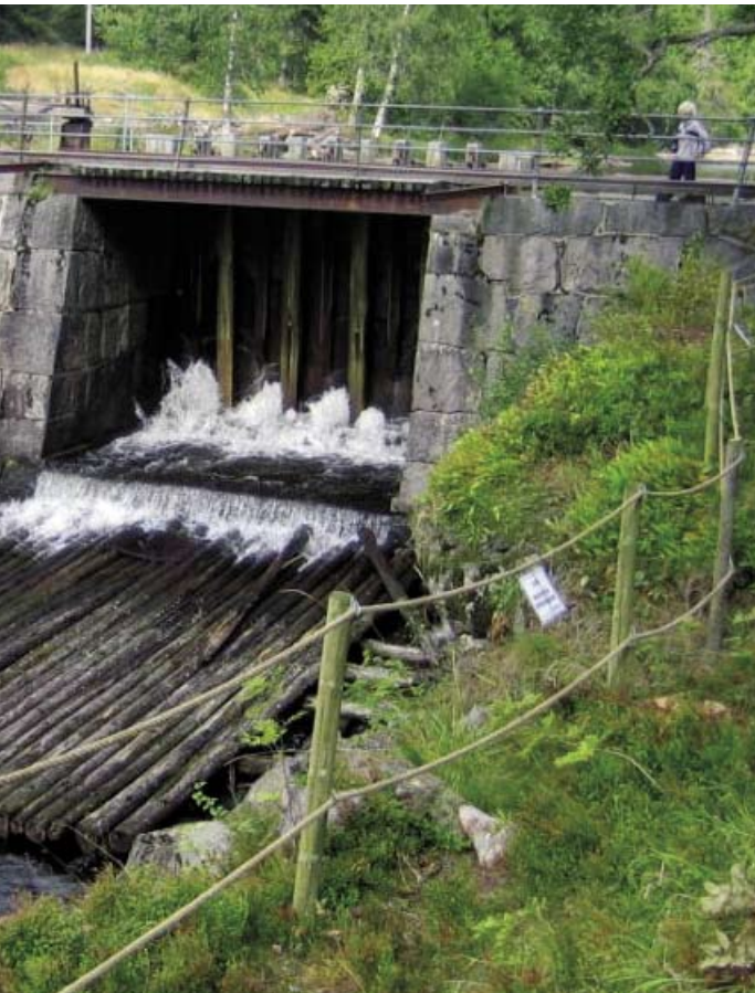
Murdam frå 1887, bygd til tømmerfløyting, ved Sandungen i Nordmarka, Oslo kommune.
