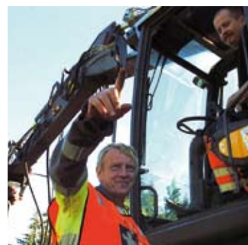
Oppsynsmann Bjørn Jensen er sikkerhetsmann mens maskinkjører Per Erik Lindsetmo rydder vegetasjon langs linjen. Foto: Øystein Grue
