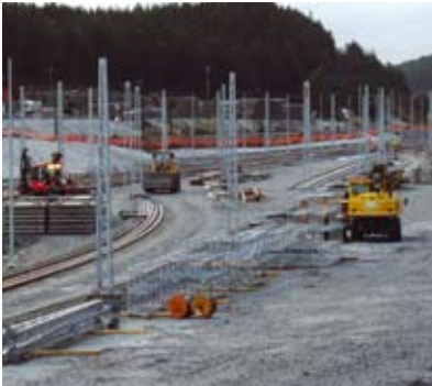
Utbygging av Ganddal godsterminal. Foto: Kjell Bakken
