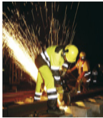
Kutting/tilpassing av skinner.
