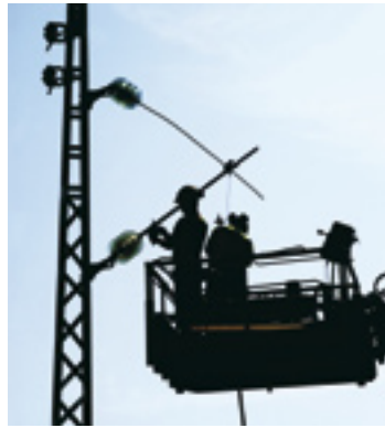
Montering av kontaktledning.
