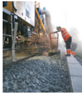
Rensing av ballast.
