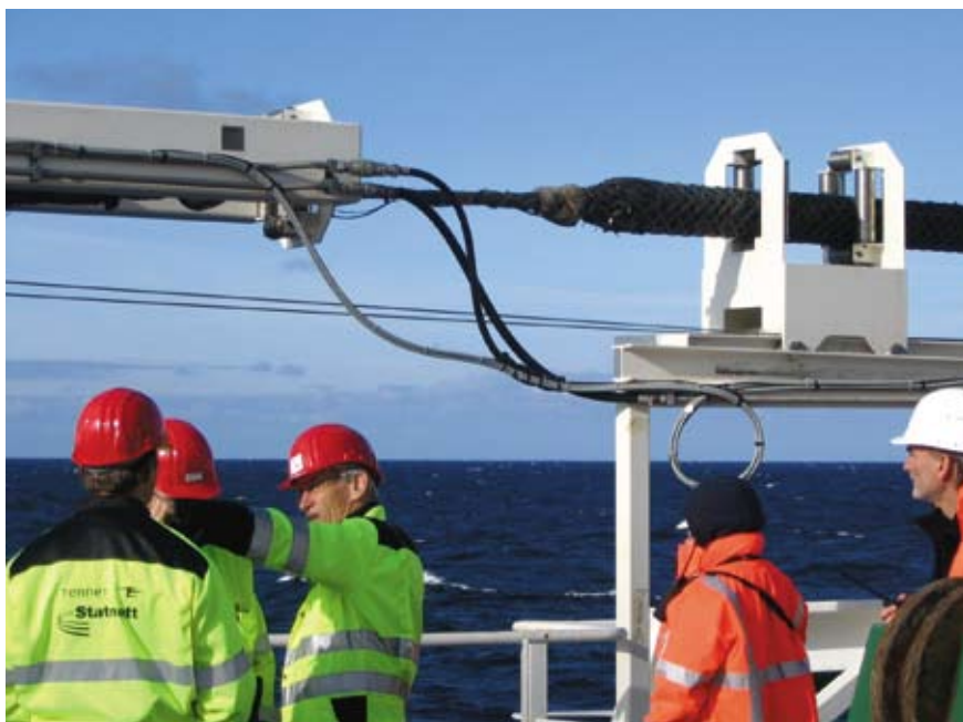
I løpet av perioden 2006–2007 ble det lagt kabel på hele den 580 km lange strekningen mellom Norge og Nederland. NorNed-forbindelsen er nær dobbelt så lang som verdens nest lengste undersjøiske kraftkabel mellom Tasmania og Australia.
