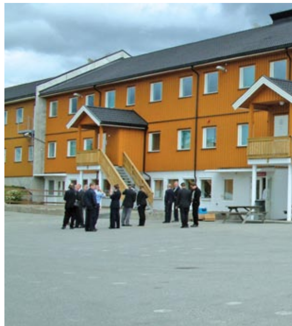
Det nye bygget har kjøkken og spisesal i den gamle kjelleren og beboerrom og spesialrom i selve bygget.
