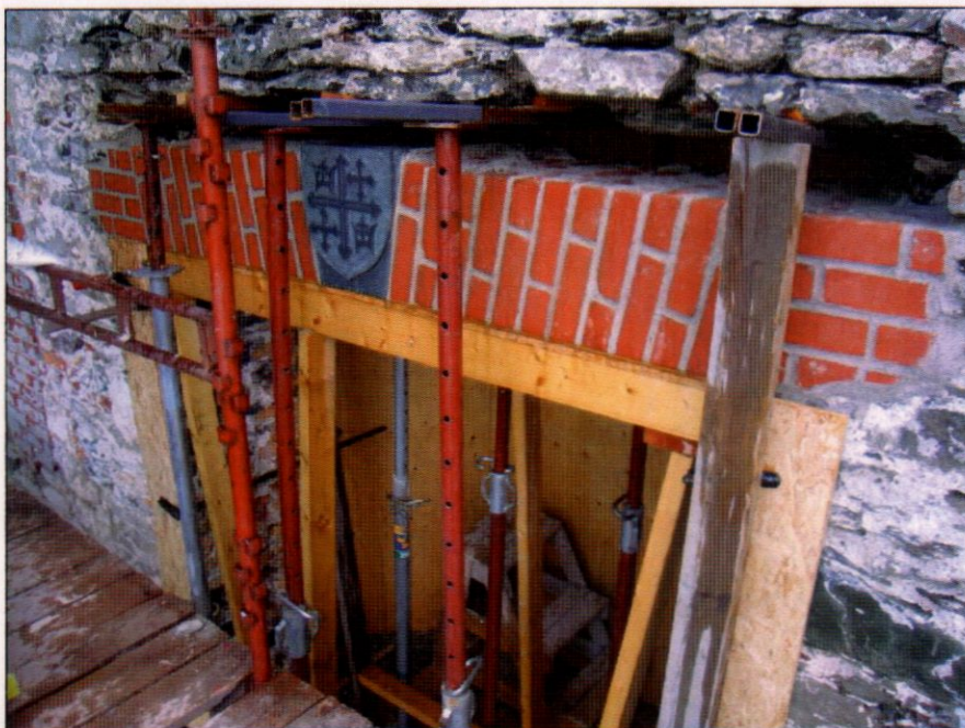
Fra Bakeriveggen i Erkebispegården. Montering av våpenskjold over dør. Middeltalermuren er avdekket før pussing.
