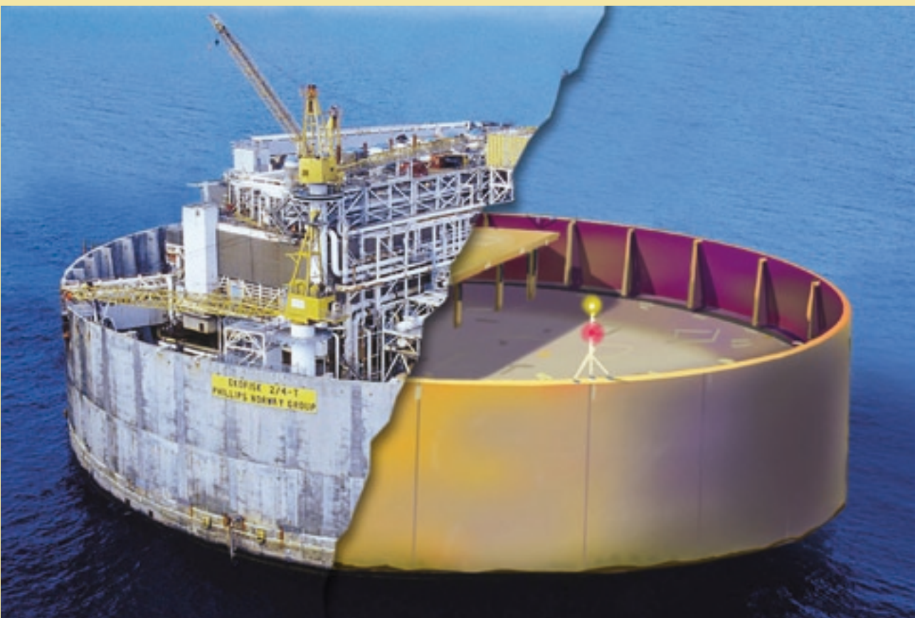
Figur 6.2 Illustrasjon av Ekofisktanken før og etter fjerning av overbygninga
