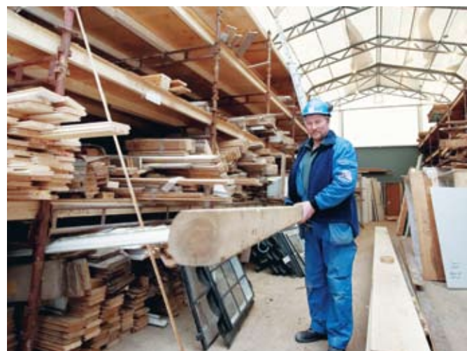
Statsbygg har fått mye ros for arbeidet med å restaurere Kongsgården på Bygdøy. Materialer som skulle brukes på nytt ble merket, nummerert og lagret i en hall.
