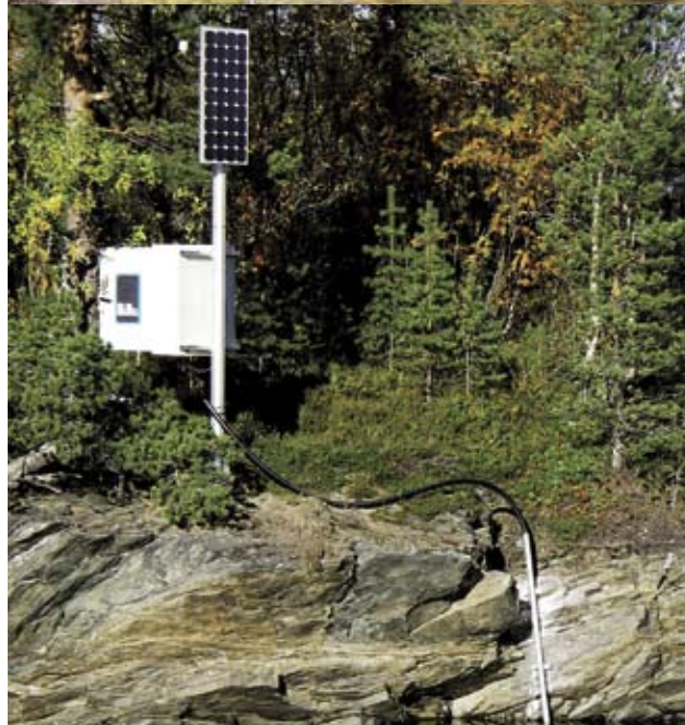
Montering og oppgradering av målestasjoner
