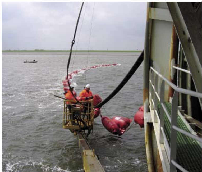
Fra leggingen av Nor-Ned kabelen.
