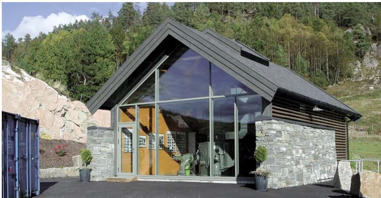
Oftedal kraftverk i Sirdal kommune
