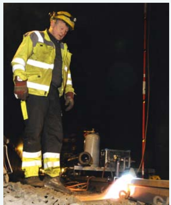
Skinneskift: Nye skinner kommer på plass i Oslo tunnelen.
