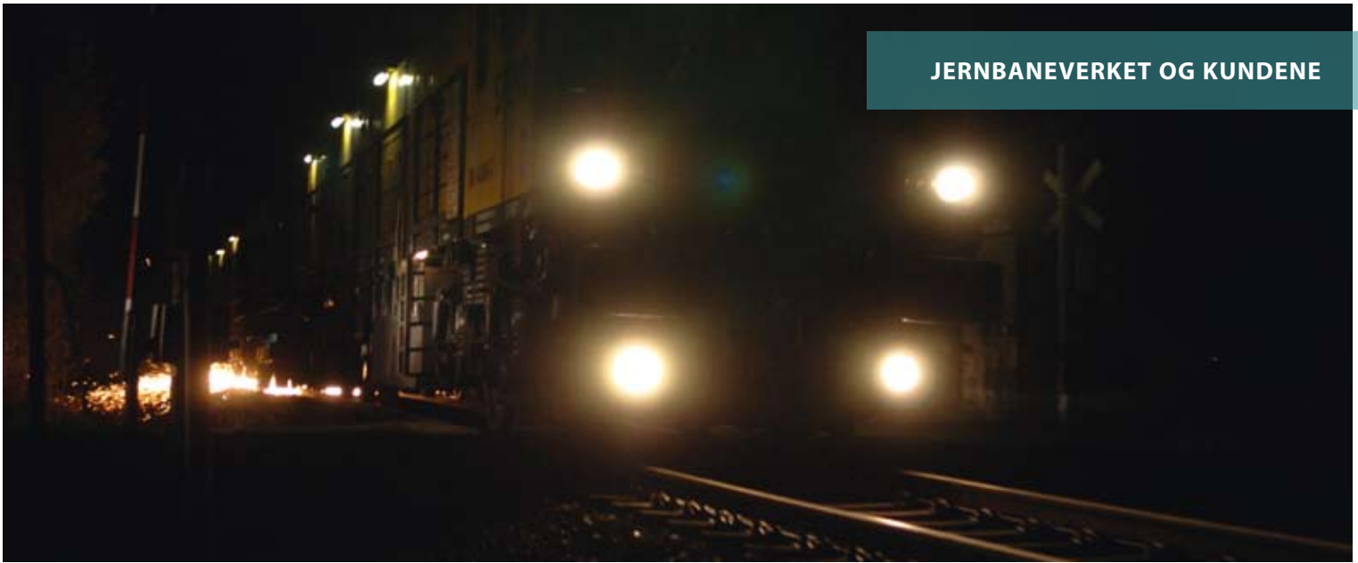
Nattarbeid: Skjenesliping skjer ofte om natta. Slipetoget er 100 meter langt og veg 300 tonn.
