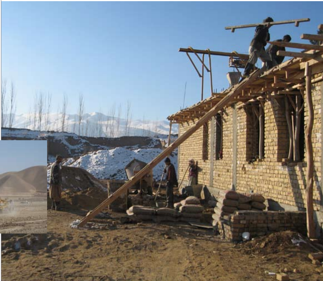
Lokale arbeidsfolk i sving med å støpe taket på en av forlegningene for den afghanske hæren. Foto: Arne Biørn
