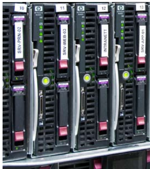
Forsvarsbygg satser på ny teknologi og vårt nye serverrom er bygget opp av fleksible komponenter for en fremtid i endring. Foto: Alejandro Perez
