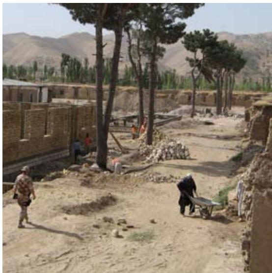
Bygging av kaserne for den afganske hæren. Foto: Sture Solum Andersen
