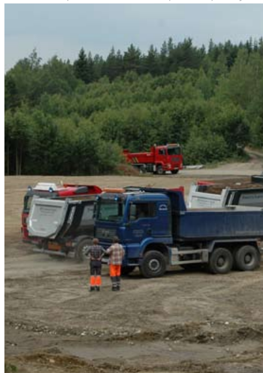
Forurenset masse på Fleskerud fraktes bort til deponi. Foto: Kjetil Nergaard
