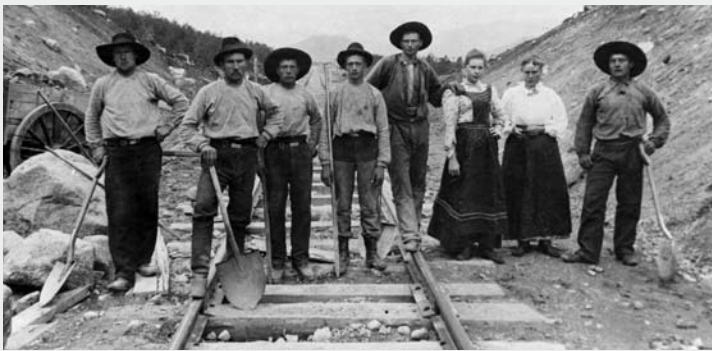
KOKKER: Det var kvinnene som midt i det arktiske fjellandskapet sørget for mat, brensel, vann, og et minstemål av hygiene, for rallarene under byggingen av Ofotbanen.
