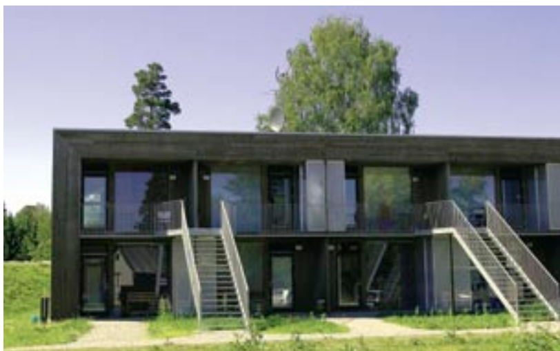
Kantum ungdomsboliger i Hokksund fikk hedrende omtale av byggeskikkjuryen i 2007. Foto: Code arkitektur AS
