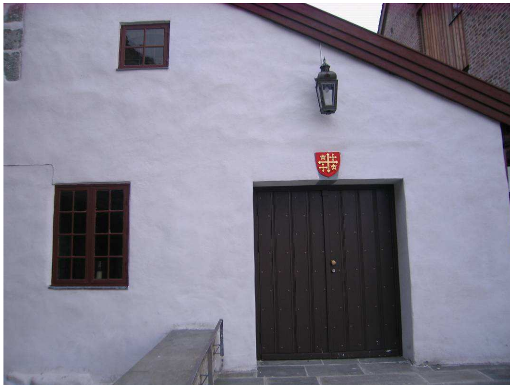
Bakeriveggen med sluttstein og restaurert dør.
