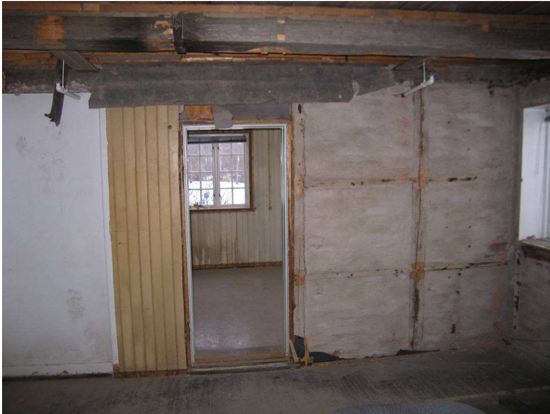
Mange lag må skånsomt demonteres for å finne historikken til bygget
