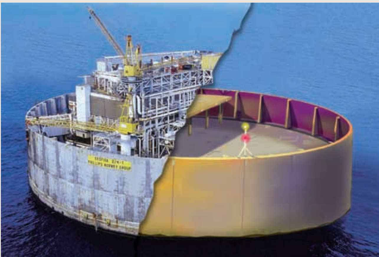
Figur 7.2 Illustrasjon av Ekofisktanken før og etter fjerning av overbygninga (Kjelde: ConocoPhillips)
