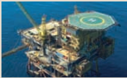
Figur 7.1 Bore- og produksjonsinnretninga DP2 som skal fjernast frå Friggfeltet (Kjelde: Total E&P Norge AS)
