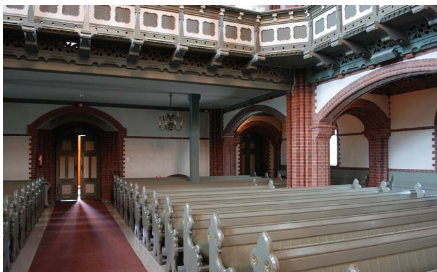
I samband med bygging av nytt orgel i Trefoldighetskirken i Arendal, blei behovet for å stiva av orgelgalleriet med søyler ei utfordring i forhold til å ta vare på den arkitektoniske kulturarva kyrkja representerar. (Foto: ATB/G. Myre)
